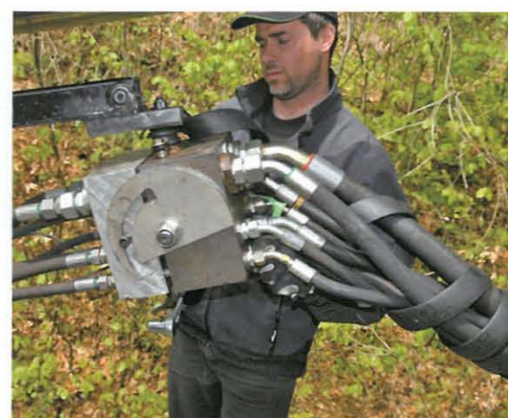
Links: Franz Habersatter steckt das Schlauchpaket mit integrierter zehnpoliger Steckdose zusammen. Durch die halbrunden Haltebügel kann die Arbeit von nur einer Person erledigt werden.
