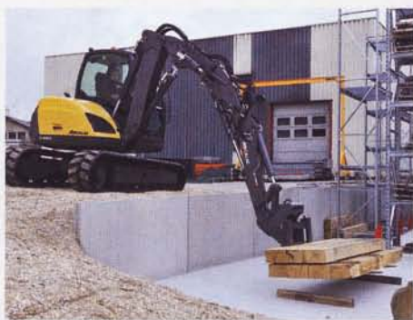
Das Multitalent ersetzt sogar den Radlader: Sichere Unterflur-Materialablage mit der Palettengabel. | Foto: Mecalac Ahlmann
