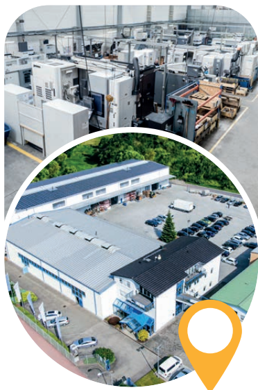
LEIPZIGER STRASSE 53-55 63607 WÄCHTERSBACH / AUFENAU
